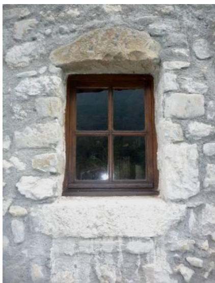
Fenêtre restaurée face Sud
