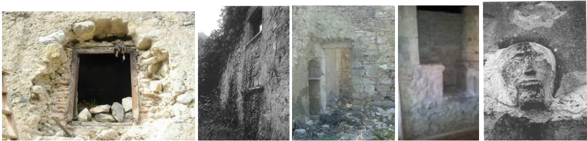
Face Sud Tête en façade Est (qui d'après les légendes, protégeait les bâtisses)
