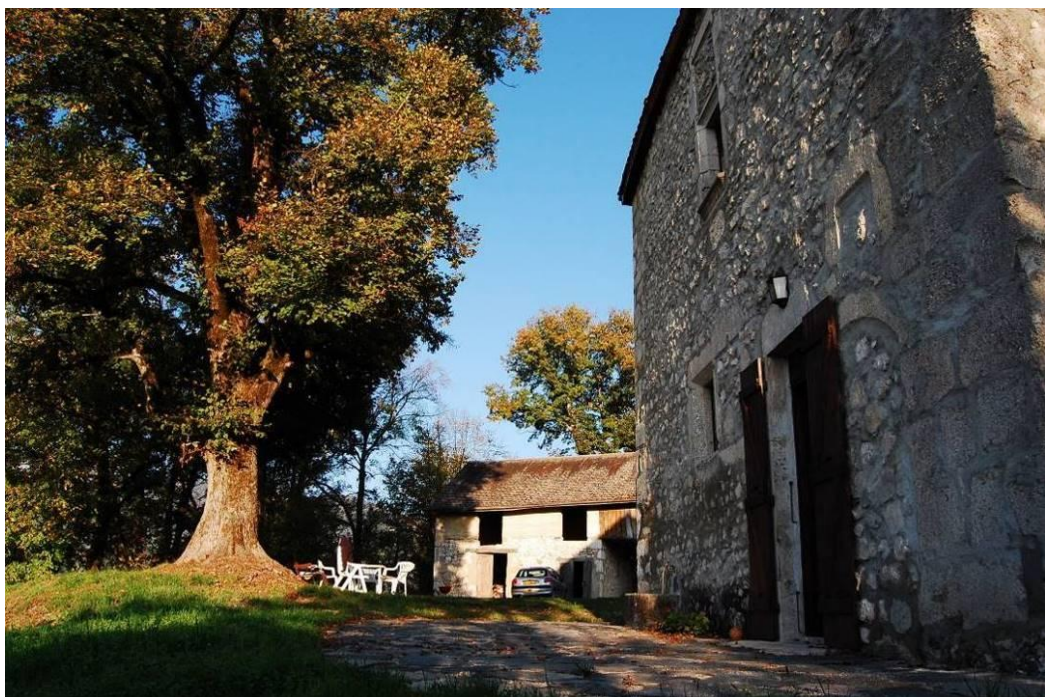
Vue Ouest du bâtiment d'habitation et la grange
