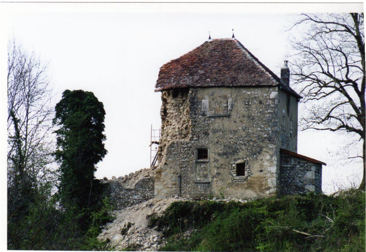
▼ La Petite Forêt avant sa restauration ▲
