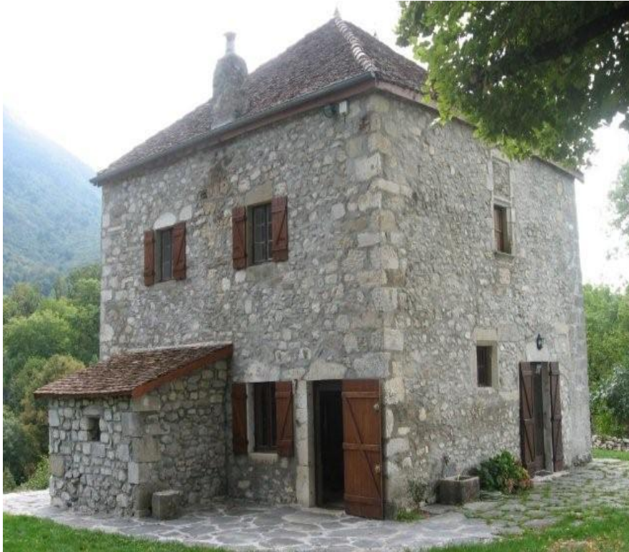
Vue Sud-Ouest du bâtiment d'habitation
